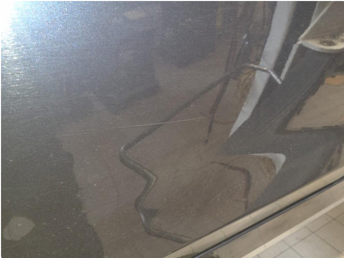
1.1 Ripe ned til grunning
